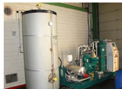
Installation du chauffage consommant de l'huile alimentaire usagée
